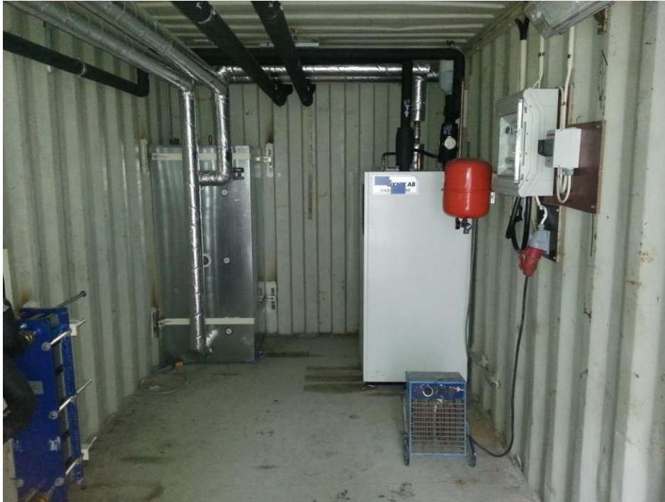
Figur 5. Bilden visar värmepumpen (till höger i bild) och ackumulatortanken. Dessutom ser man till framför värmepumpen ett värmeelement på 9 kW.
