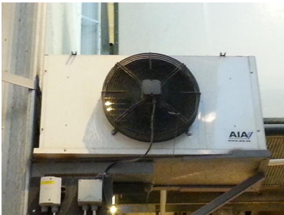
Figur 7. Bilden visar fläktkonvektorn som levererar varmluft till vattenreningsverket.
