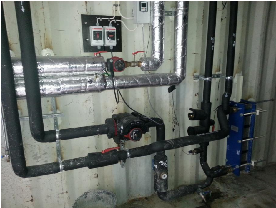
Figur 6. I ledningarna med svart isolering pumpas kylvatten från tunnelbormaskinen via filter och värmeväxlare (till höger i bild). I ledningarna med silver färgad isolering pumpas glykol till fläktkonvektorn.
