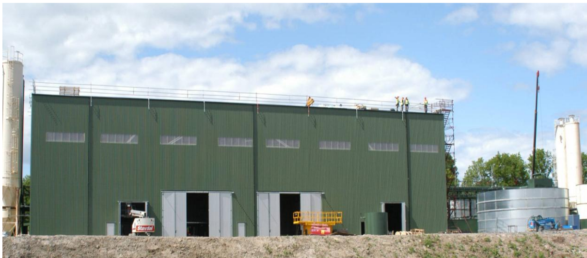
Figur 3. Bilden visar vattenreningsverket (Slurry treatment plant) på projekt Hallandsås där energicontainern installerades för att bidra till uppvärmningen.
