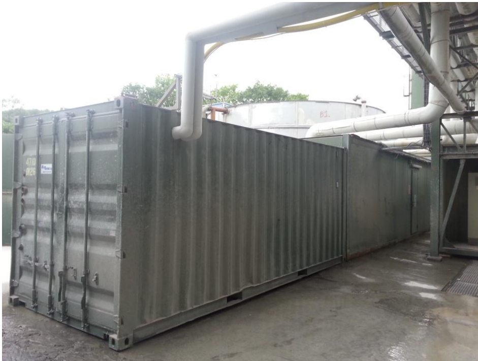
Figur 4. Energicontainern byggdes av en konventionell 20-fots container. På bilden visas containern med installationen till vattenreningsverk närmast i bild och cistern och pumphus till kylvat- tensystemet för tunnelborrningsmaskinen i bakgrunden.
